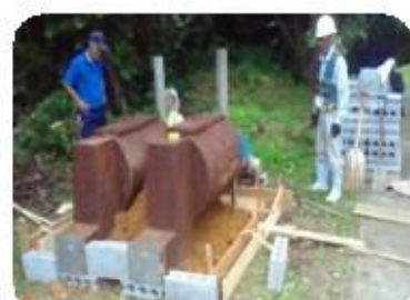
①窯の基礎工事
